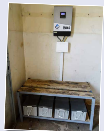
Durch die Umwandlung der Sonnenenergie stehen jetzt täglich 0,5–5 kW pro Stunde zur Verfügung.
