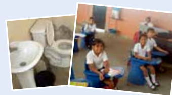
Die sanitären Anlagen und ein Klassenzimmer wurden optimiert – so dass man beides gut benutzen kann.
