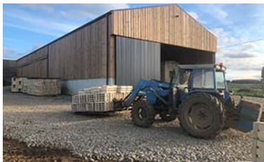
Der Hof liegt in Carantec an der Nordküste der Bretagne.
