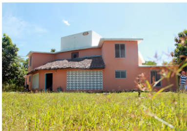
Dies ist der Neubau des Kindergartens 2009, hier arbeiten ausgebildete Waldorf-Pädagoginnen.
